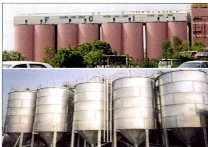
चित्र 3: एफसीआई, मायापुरी, नई दिल्ली में कंक्रीट साइलो और वाणिज्यिक हॉपर बॉटम स्टोरेज साइलो
